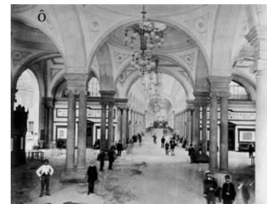
Blick in die Mittelhalle
