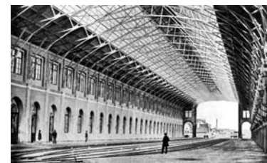
Eine der beiden Bahnsteighallen
